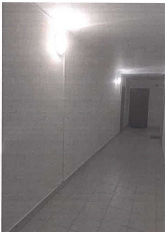
Fot. Lazurowa 6 kl. – wyremontowane korytarze z ułożonym gresem
