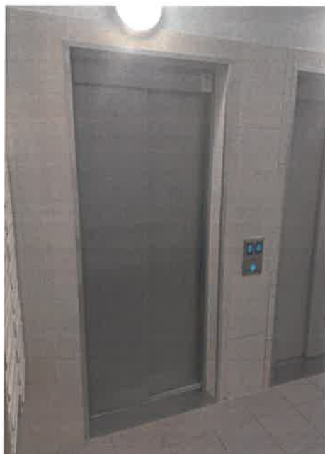
Fot. Nowy portal wokół drzwi do wind w budynku Lazurowa 2 wykonany z gresu
