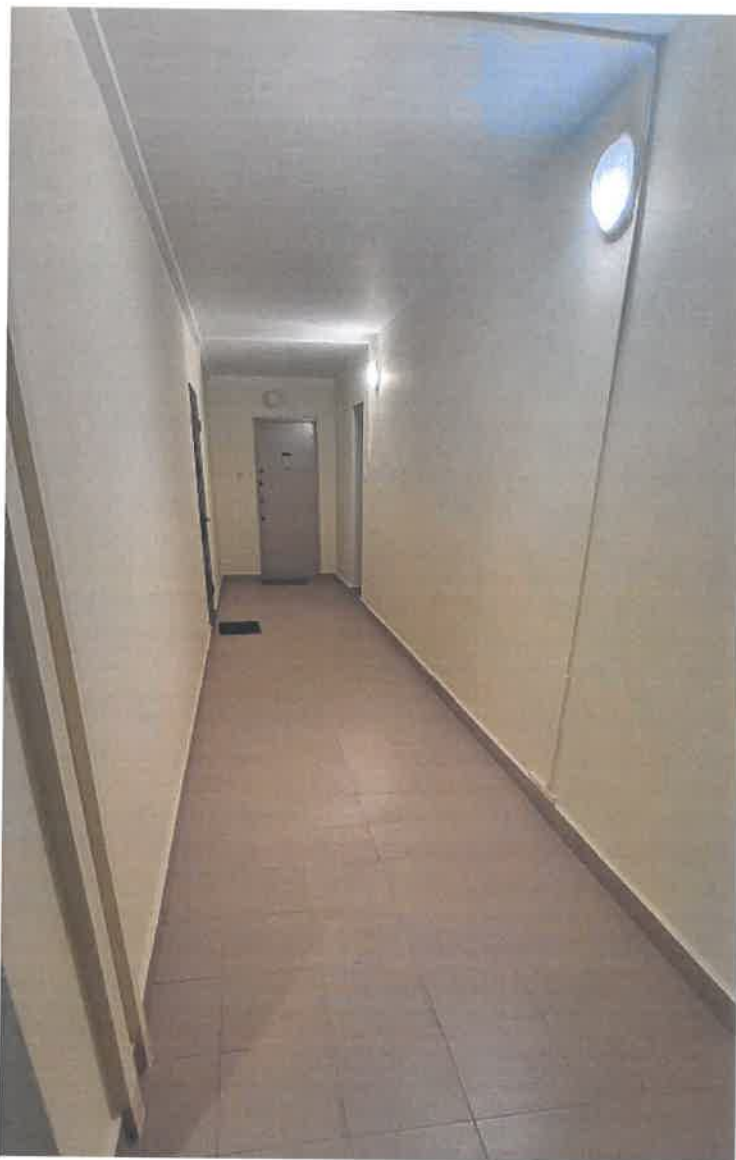
Fot. Lazurowa 6 kl. III ułożony gres na posadzce i odnowiona klatka schodowa
